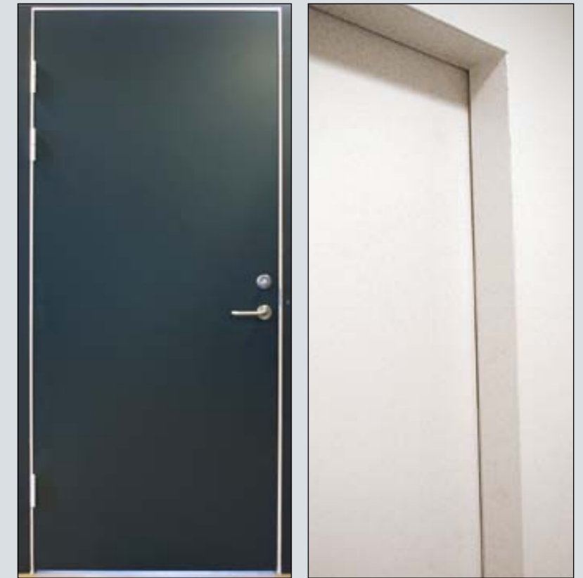
På hængselsiden ses kun hængslerne, mens selve dørbordet smelter sammen med resten af væggen. På bagsiden ses karmen slet ikke, blot døren, som nærmest svæver i dørhullet.
